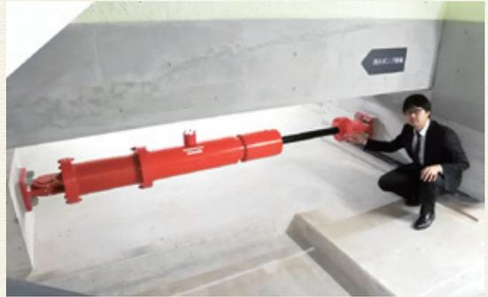
▲本社下のボールねじの入ったダンパーが地震のエネルギーを吸収する
